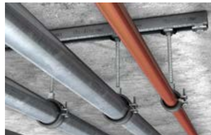
Крепление трубопровода с помощью монтажных шин
