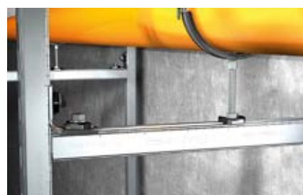
Крепление трубопровода на рамной конструкции
