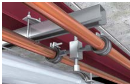
Крепление с помощью монтажного кубика
