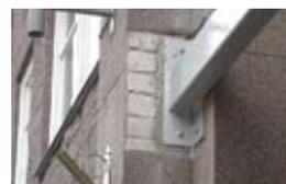
Монтаж несущих элементов рольставней к кладке из силикатного кирпича
