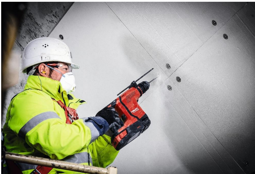
Крепление сборных противопожарных панелей
