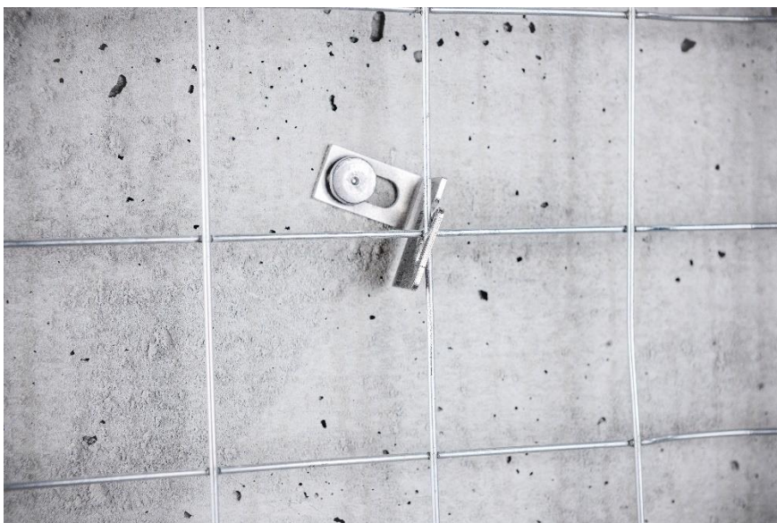
Крепление легкой металлической сетки для нанесения противопожарного раствора
