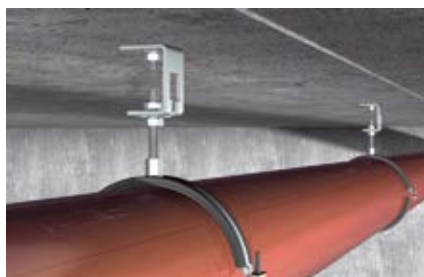
Монтаж трубопровода с регулировкой по высоте
