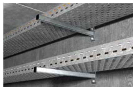
Крепление кабельного лотка на консоль
