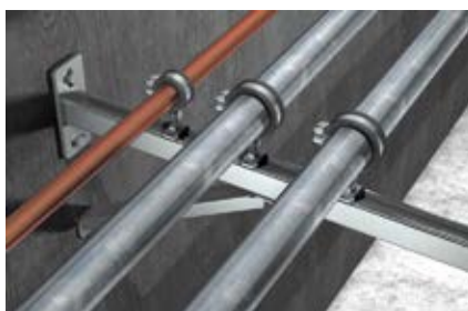
Крепление трубопровода к стене
