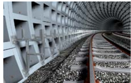
Монтаж в туннелях
