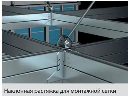
Наклонная растяжка для монтажной сетки
