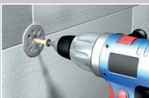
Geschraubter Dübel auf Polystyrol Platte
