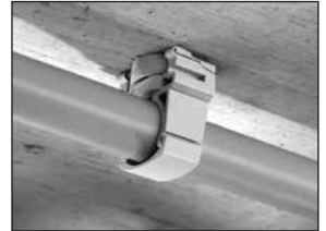
Cable conduits or light duty pipes
