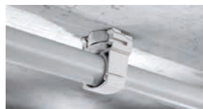
Cable conduits or light-duty pipes
