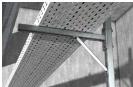
Крепление кабельного канала на консольную конструкцию
